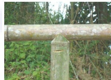
竹子連結處用鋸子挖洞
