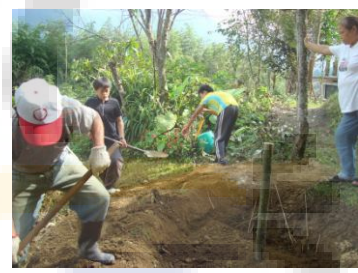
插上打通竹節的竹管後覆土
